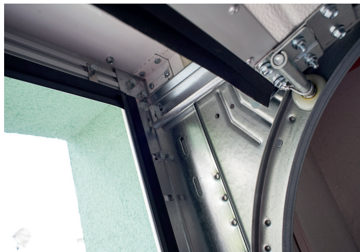
▲ RSV; Detail des Rahmens und der Laufschienen
