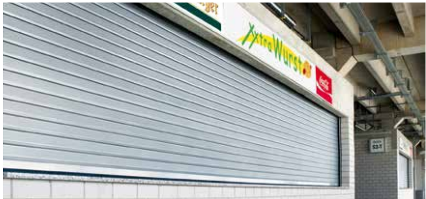
Speziallösung (extreme Torbreite) in einem Fußballstadion
