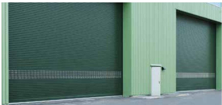
Hallenabschluss in einem Industriebetrieb
